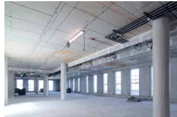
Een gebouw van 14 verdiepingen hoog in hartje Charleroi.
