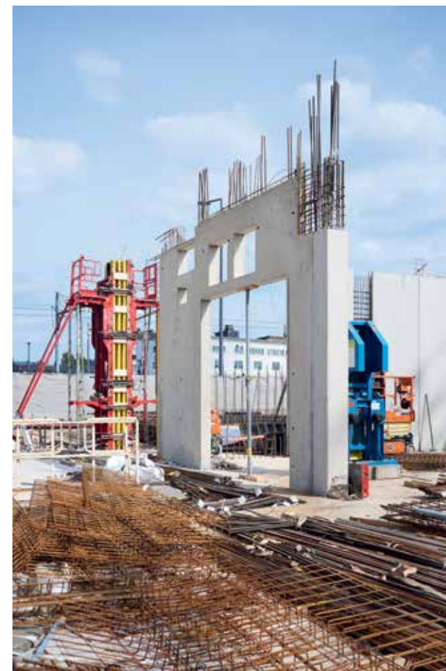
Prefabricatie: onmisbaar op deze werf.
