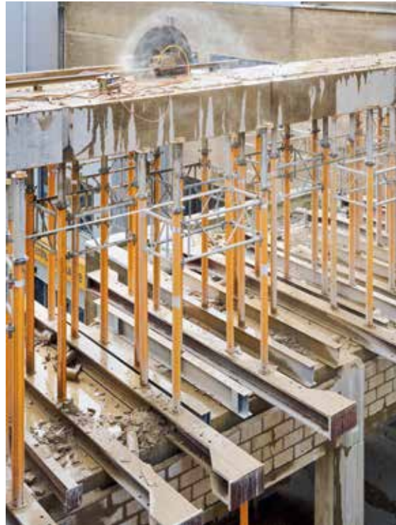
Een zaag met een diameter van 1.5 m voor betonnen balken.
