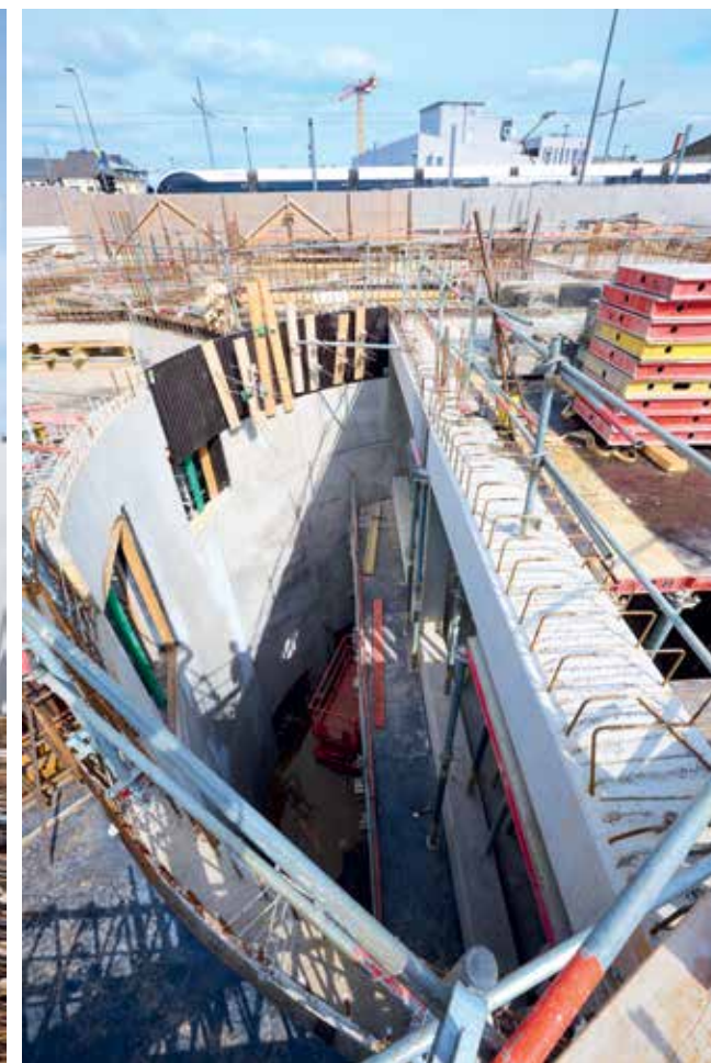
Het nieuwe administratieve gebouw rijst langzaam uit de grond.
