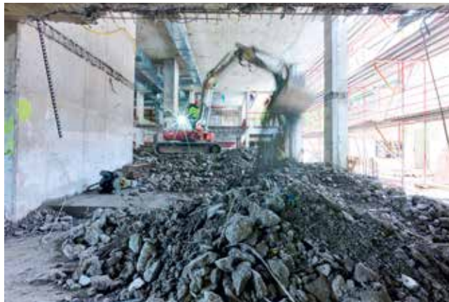
We voeren de werken uit van A tot Z: van de sloop tot de afwerking.
