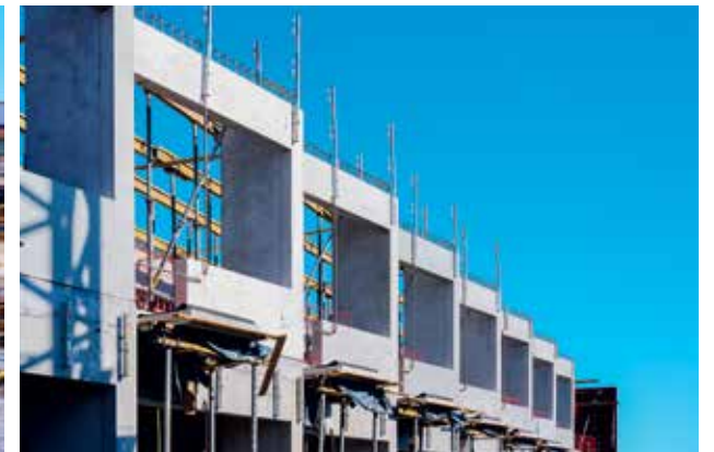
Het depot heeft 385 geprefabriceerde gevelkaders geleverd.
