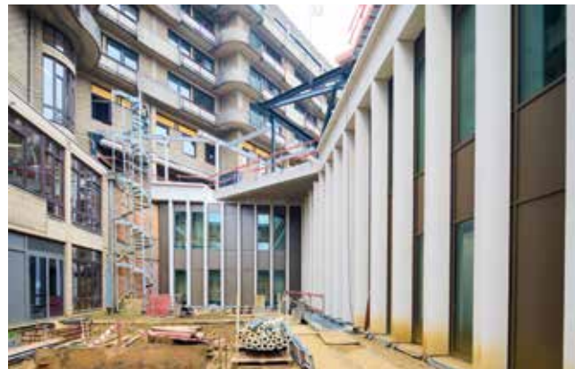
Uitbreidingswerken in het hart van het gebouw.
