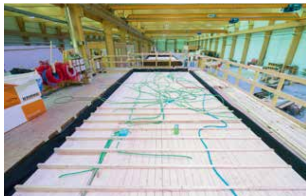
De elektrische installatie.
