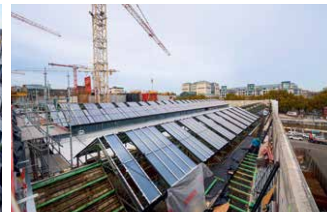
Installatie van dakelementen in lijn met de oorspronkelijke architectuur.
