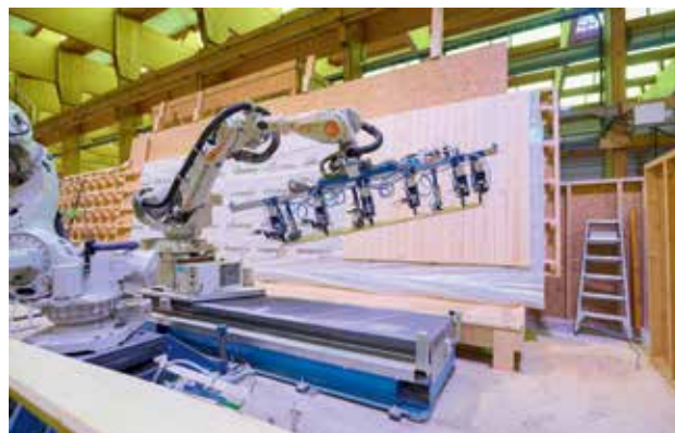
Montage van de muren (2/2).
