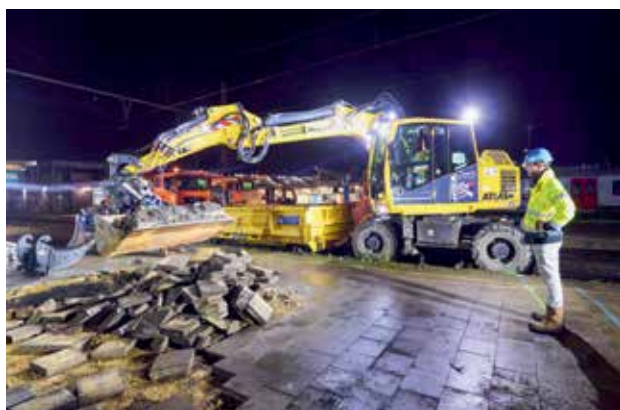
Tegels weghalen en het terrein voorbereiden.
