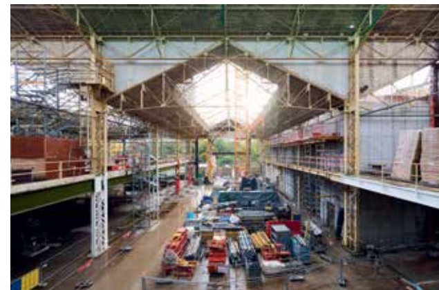
Nauwgezette logistiek om verschillende werkzones tegelijkertijd te coördineren.
