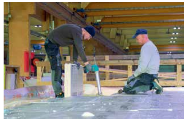
Isolatie van het dak.
