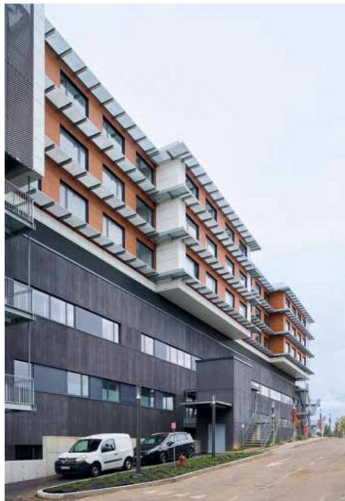
Zijgevel van de nieuwe vleugel met zeven verdiepingen.
