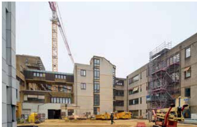
Bouwwerkzaamheden in volle uitvoering aan een vleugel van het ziekenhuis.
