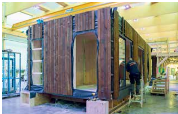
Montage van de muren en het dak (2/3).
